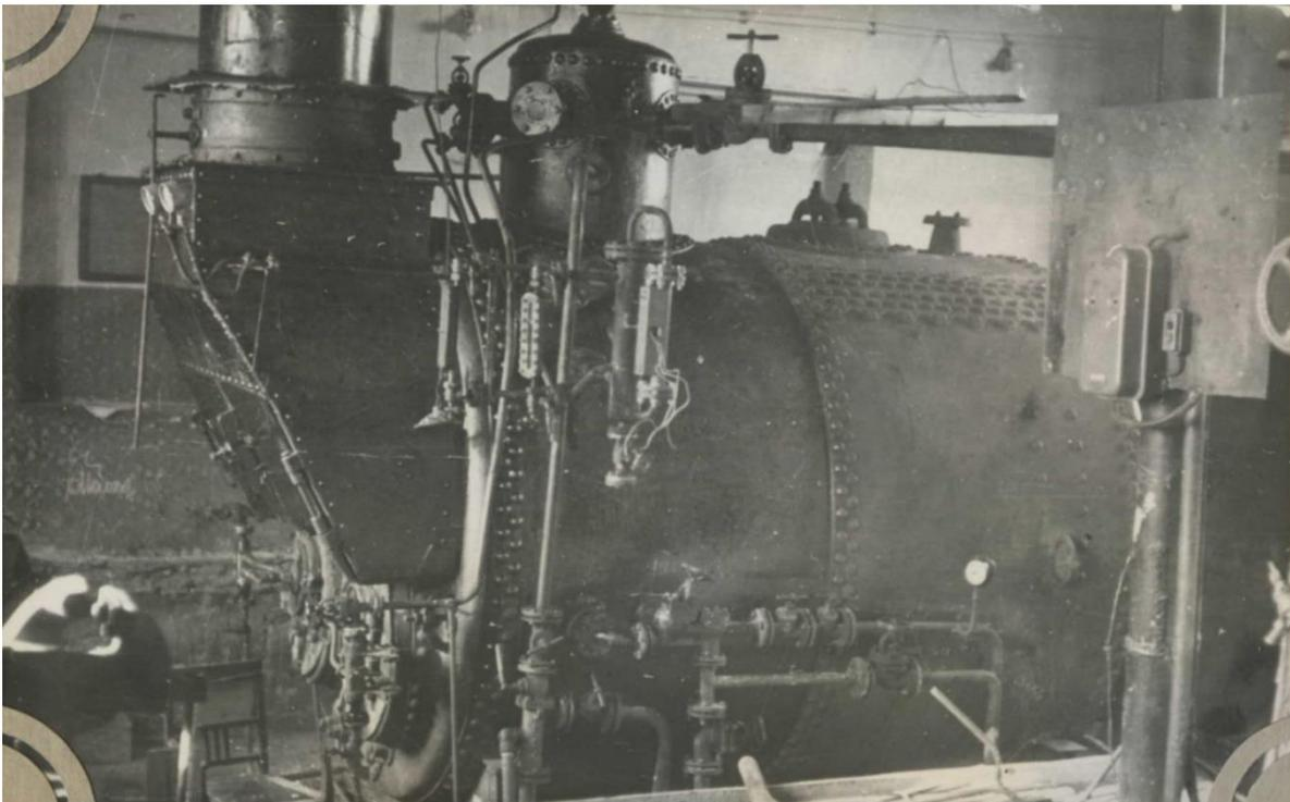
Паровой котел. Съем пара = 1500 кг/час. Установлен в 1968 г.
